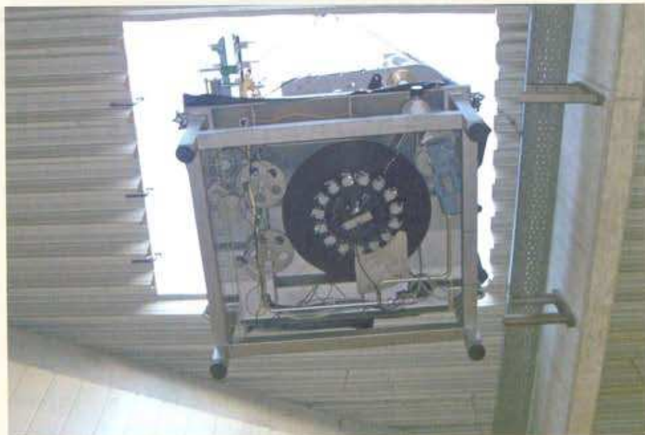
Beengte Platzverhältnisse erforderten Fingerspitzengefühl bei der Einbringung des Bügelverschleißers Fotos: AMS
